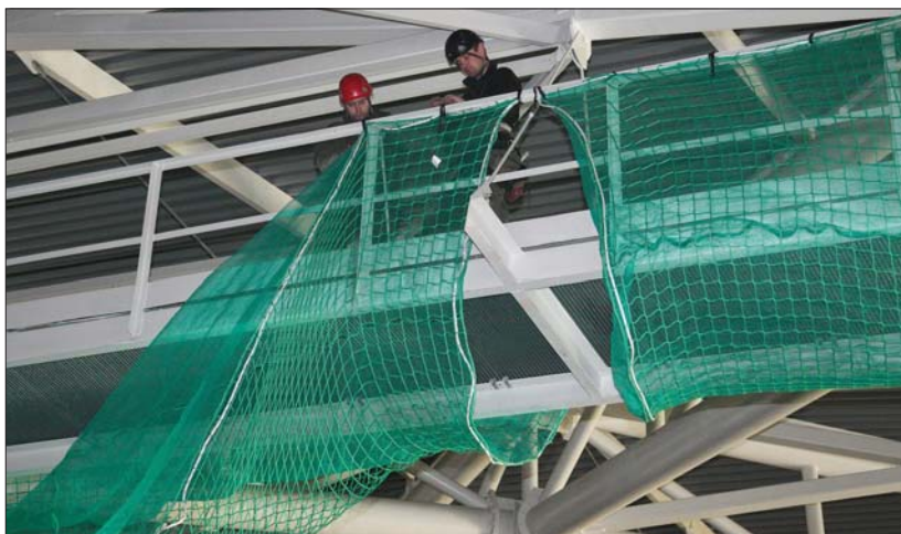
Fot. 3 Budowa hali Arena Łódź-archiwum Huck Polska
