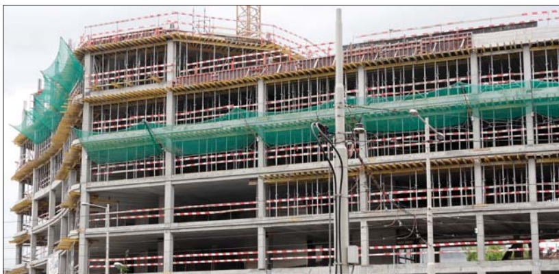
Fot. 2 Budowa biurowca Pl.Grunwaldzki Wrocław-archiwum Huck Polska
