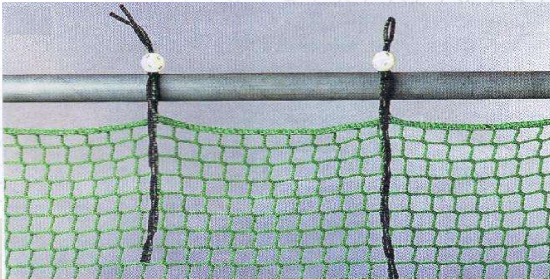
Montaż siatki za pomocą linki z klipsem Isilink
