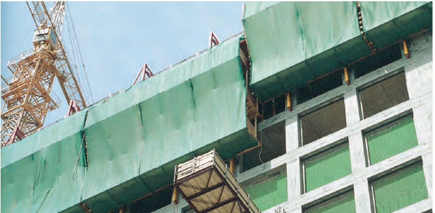
Boczne zabezpieczenie zastosowane podczas budowy Japan Centre we Frankfurcie.
