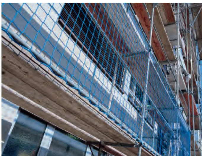
Mocowanie siatki do rusztowania.
