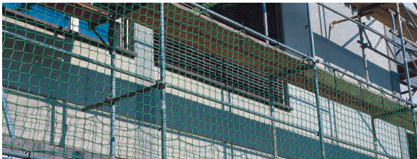
Siatka ochronna na rusztowanie, \varnothing oczka 100 mm.
