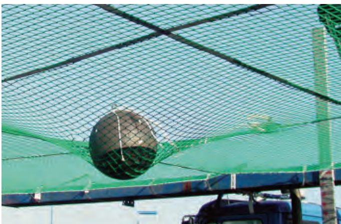
Dodatkowe napięcie siatki pasami naprężnymi, tworzące pola nie większe niż 2 x 2 m.
