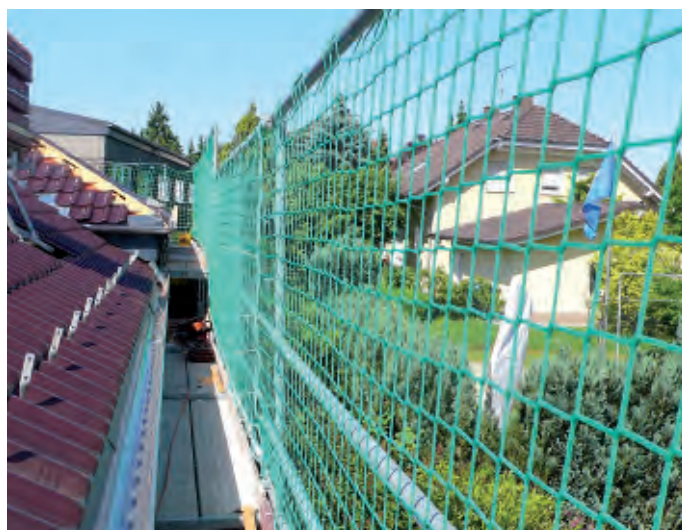
Mocowanie siatki do rusztowania.
