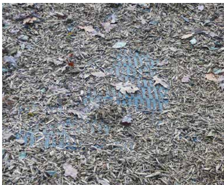
Gotowa, zamontowana mata (odsłonięta do zdjęcia).
