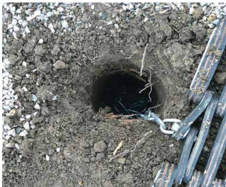
Małe otwory przygotowane do zakotwienia, średnicy ok. 5 cm.
